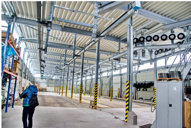
Garáž v mezistanicí lanové dráhy
