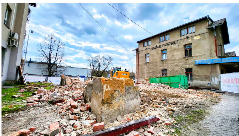
➡ Demolice nádraží začala u přilehlých objektů
